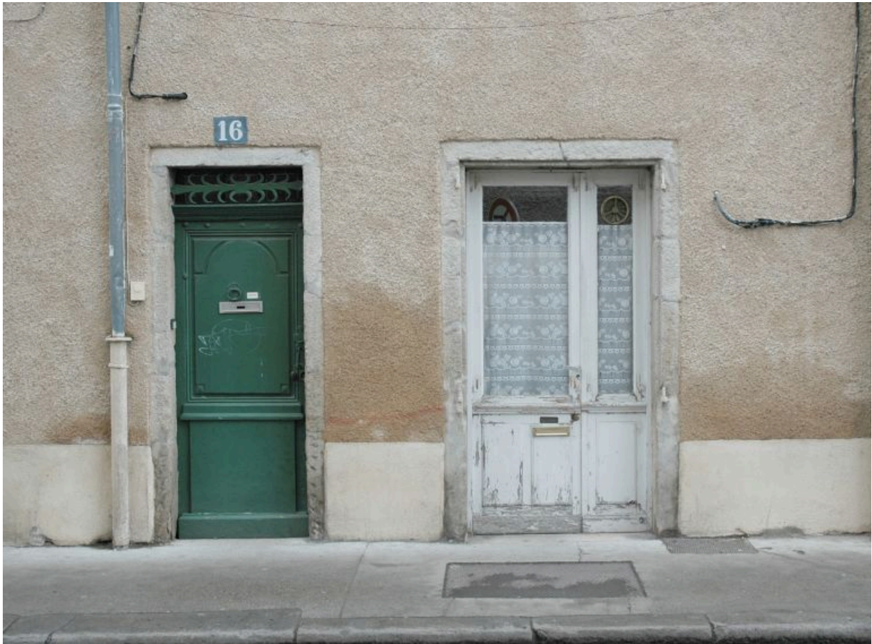
Détail, porte piétonne et porte d'ancienne boutique.
