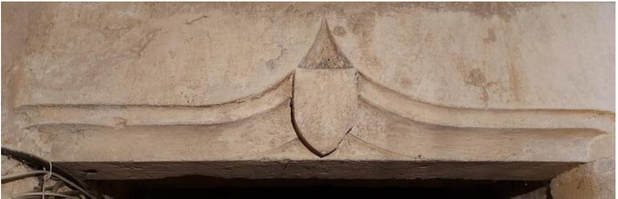
Ecusson sous un arc en accolade (dessus de porte d'accès à l'escalier)
