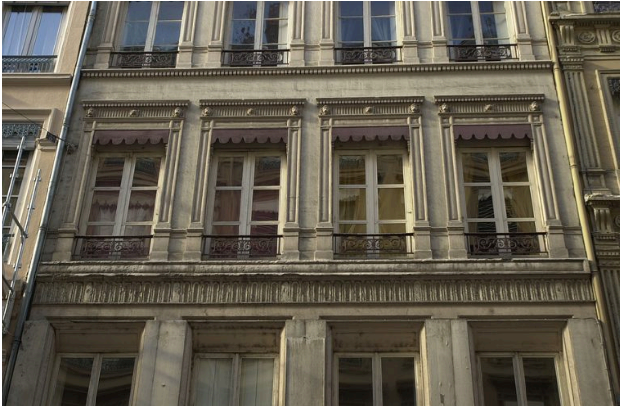
Élévation antérieure : détail des baies
