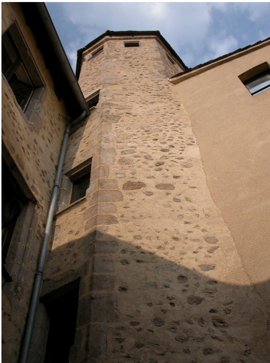
Vue intérieure de la cour : tour d'escalier, partie haute.
