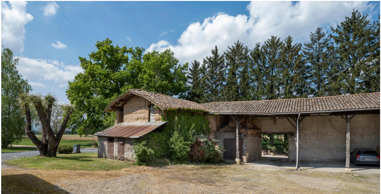
Vue des bâtiments nord, depuis la cour : hangar agricole au nord, grange et toit à porcs à l'ouest
