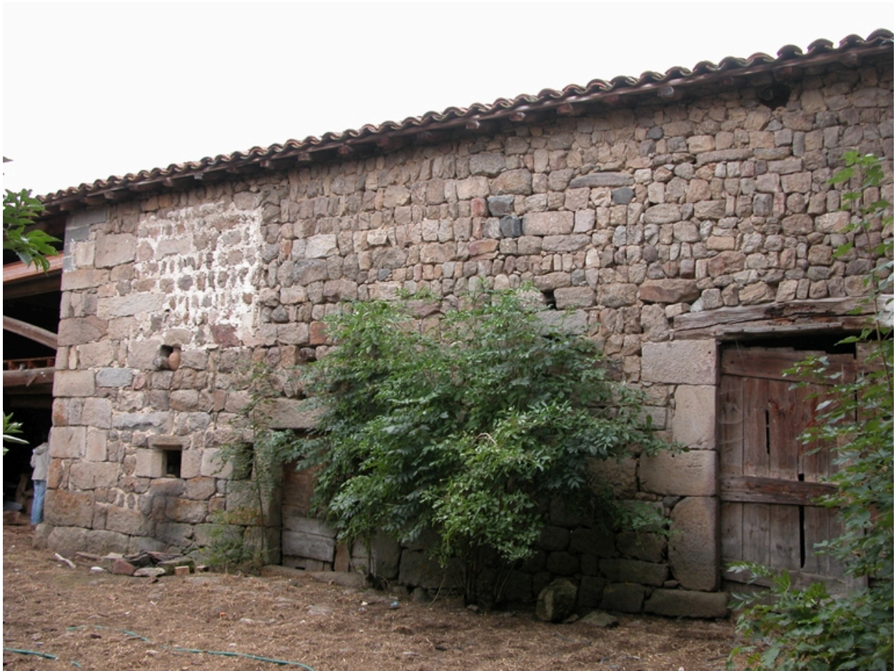
Vue d'ensemble de la grange-étable nord-ouest, depuis la cour.
