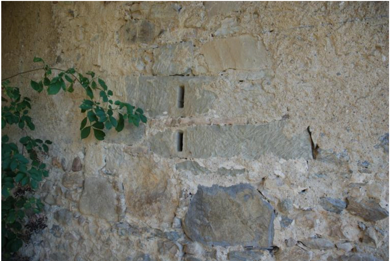
Ferme puis remise (2016 B5 310). Placard garde-manger à jours d'aération creusés dans la molasse.
