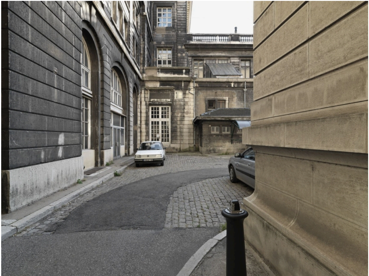
Bâtiments A et A'. Vue depuis le nord
