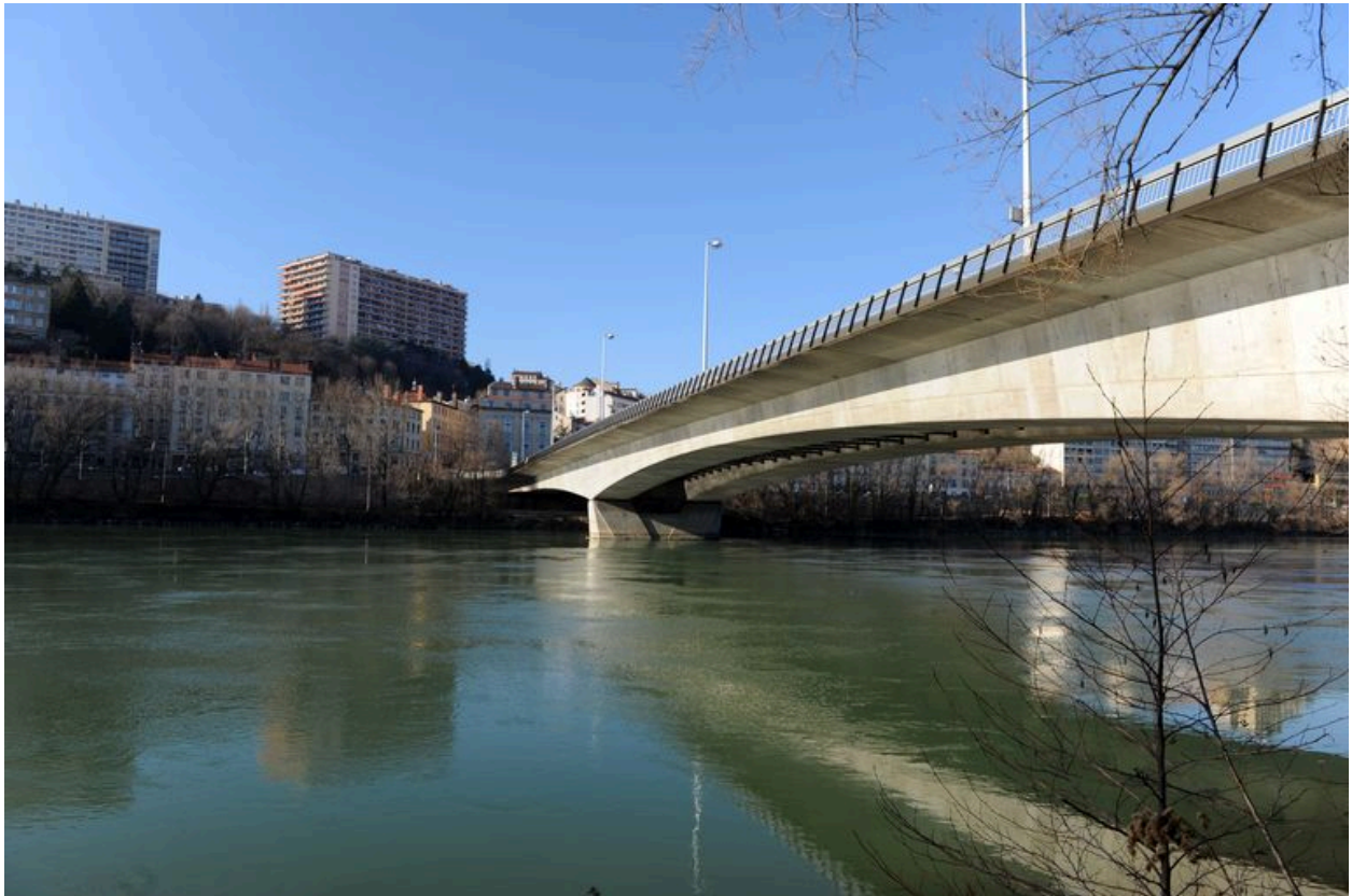
Vue partielle, de côté, travées droite et centrale, face aval (depuis la rive gauche)
