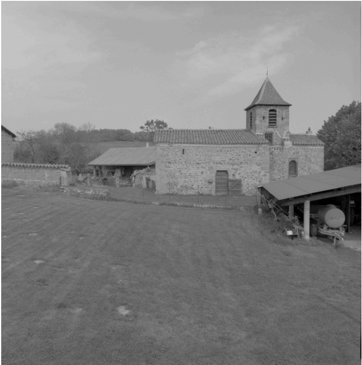
Vue générale, façade latérale droite.
