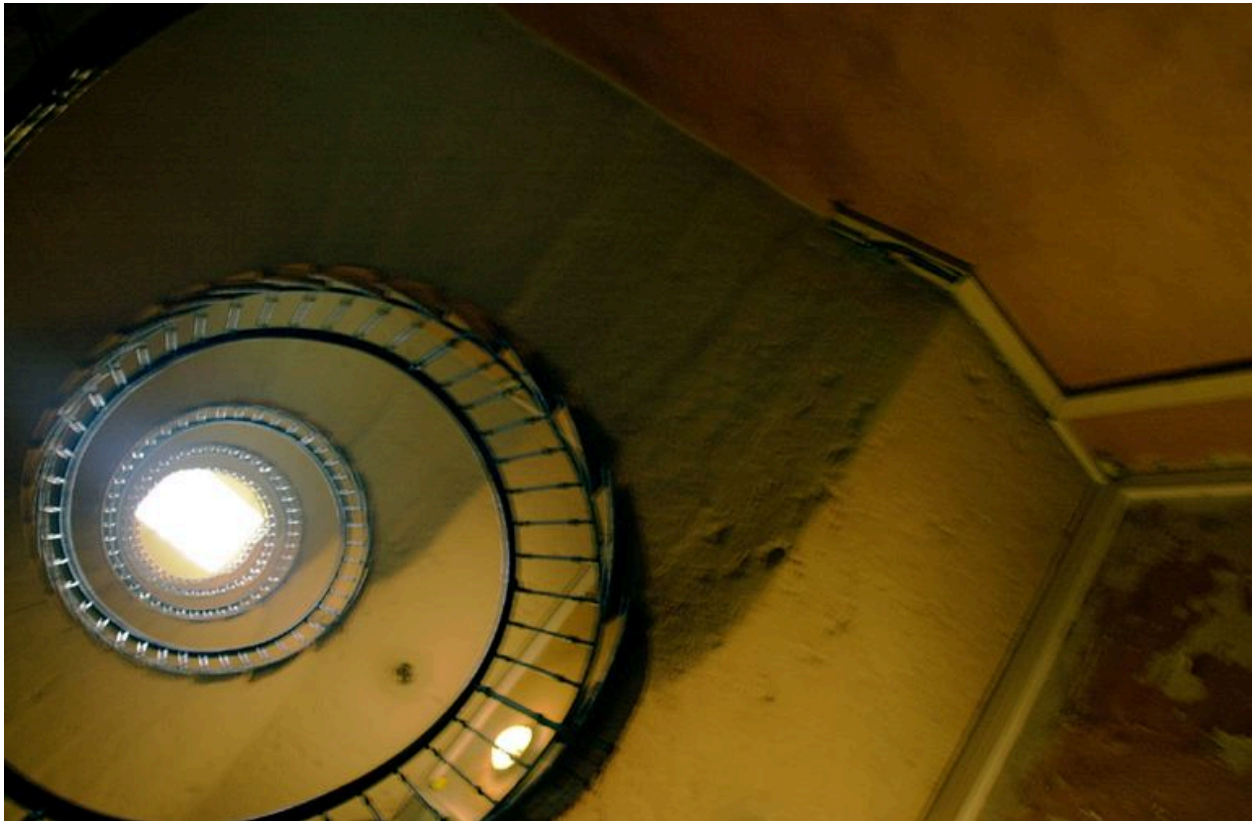
Vue de la cage d'escalier et de son éclairage zénithal
