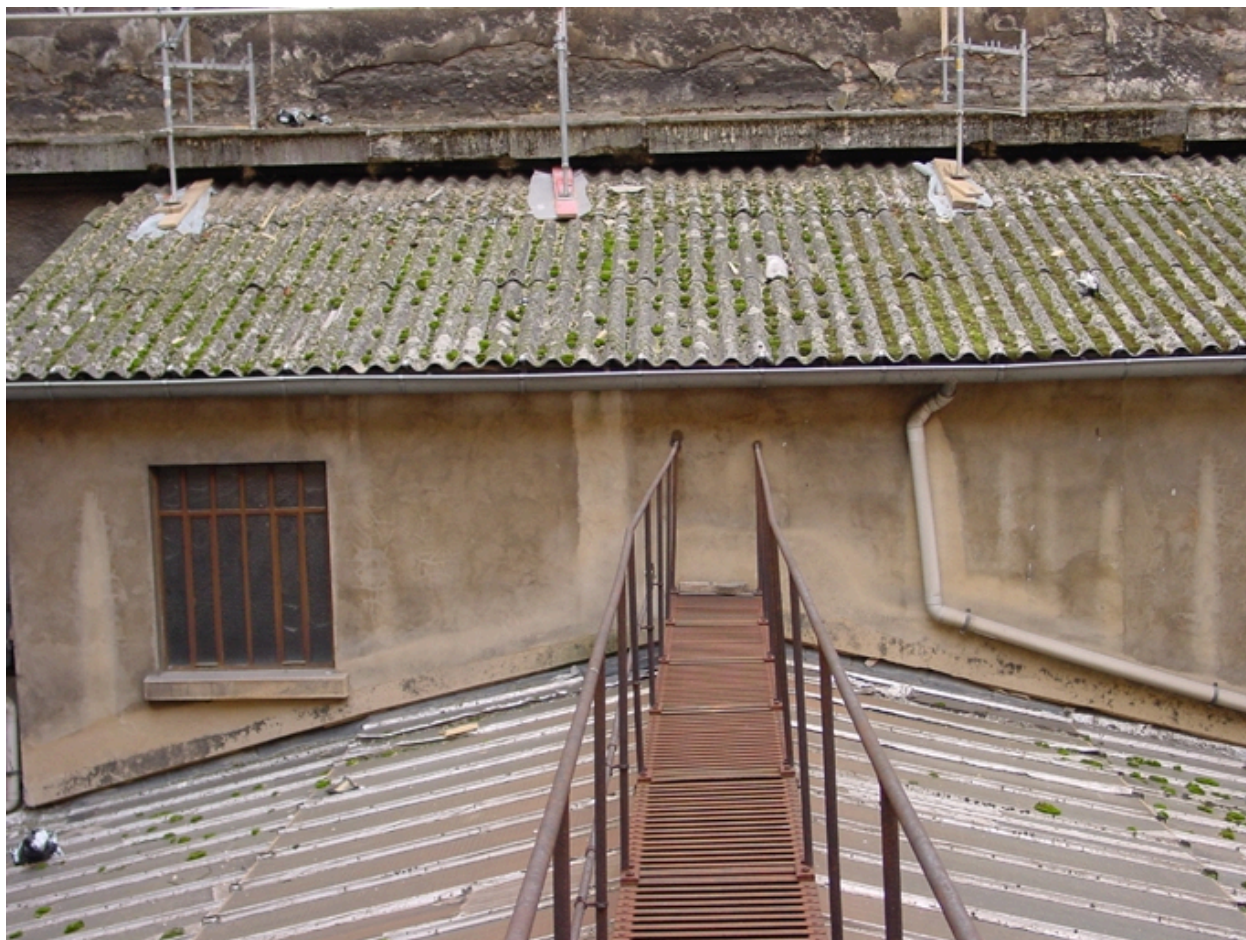
Passerelle de la verrière
