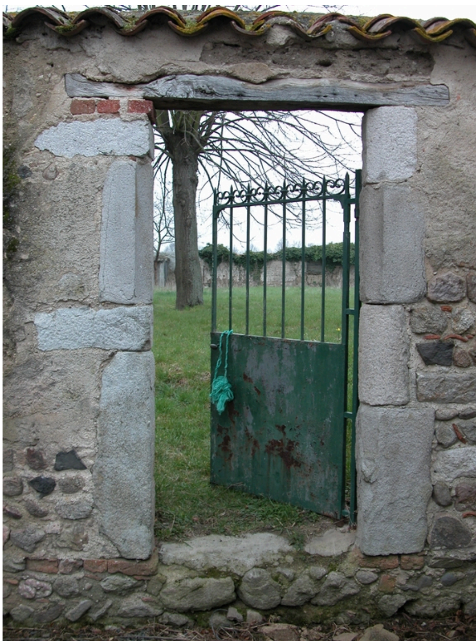
Détail de la porte piétonne entre la cour et le clos.
