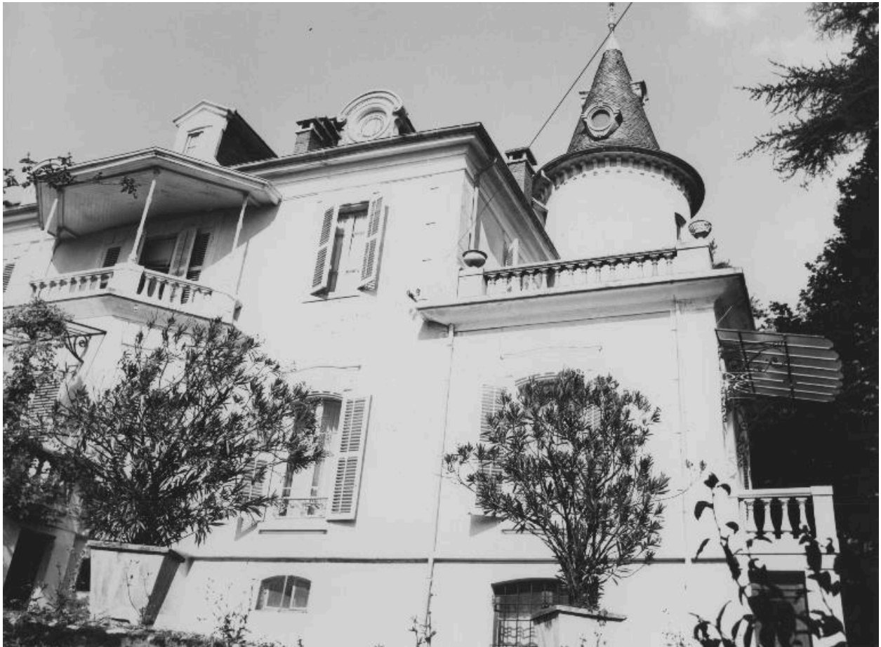
Vue prise du sud-ouest, 1978
