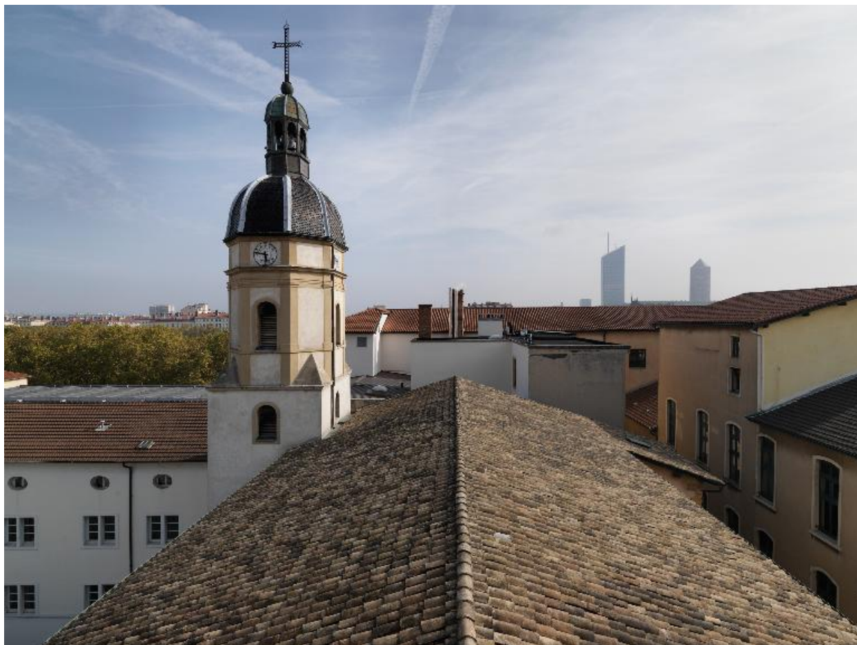
Toiture et clocher, depuis l'ouest
