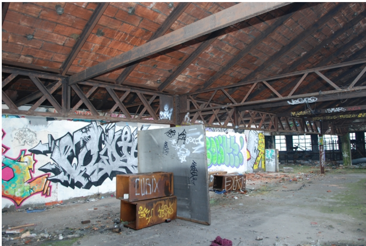
Vue d'ensemble de la charpente à hourdis en briques et poutrelles métalliques
