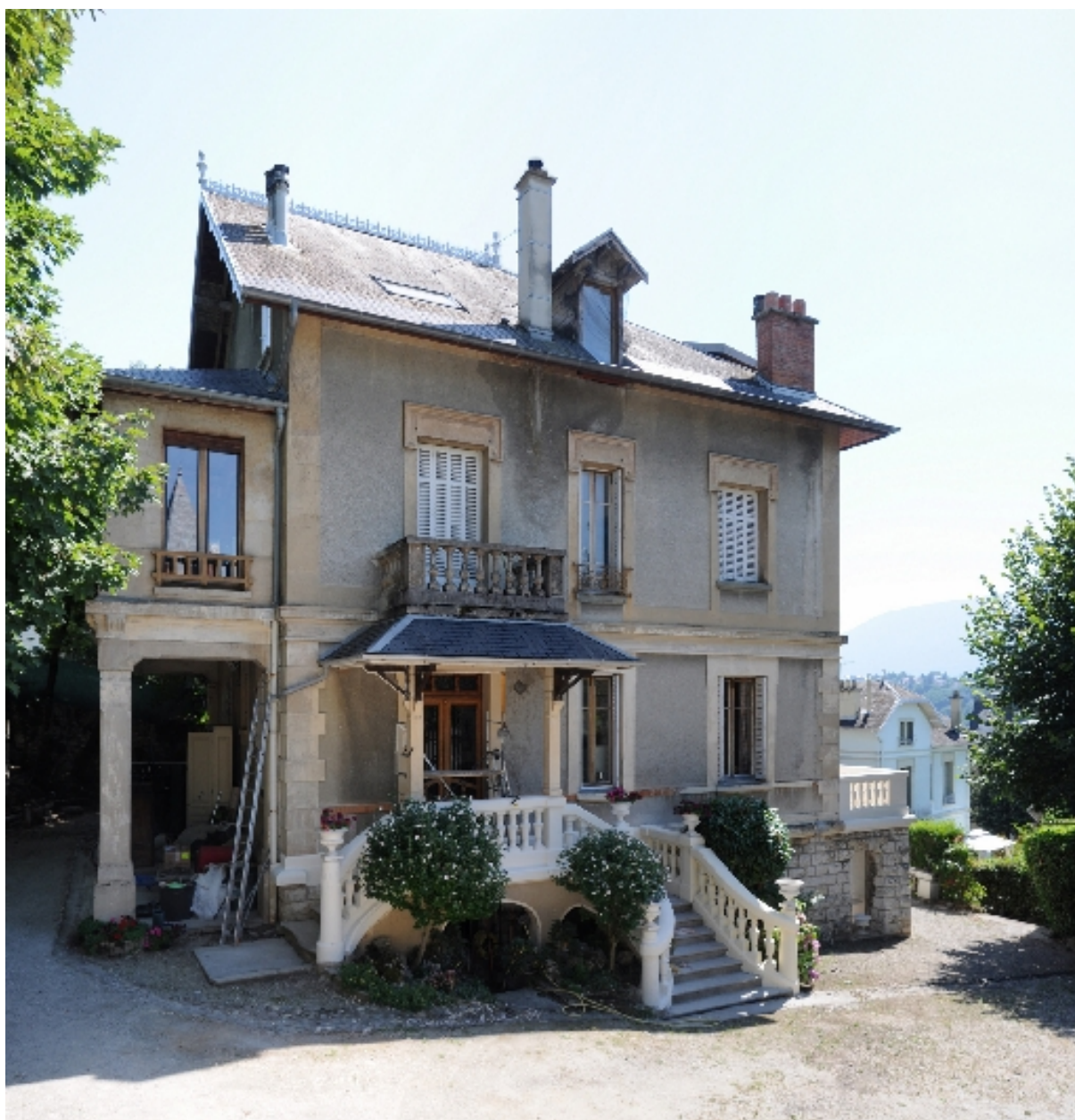
Elévation latérale, façade sur cour
