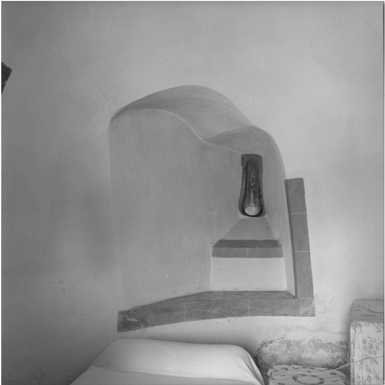
Tour ouest, détail d'une archère-canonnaire.
