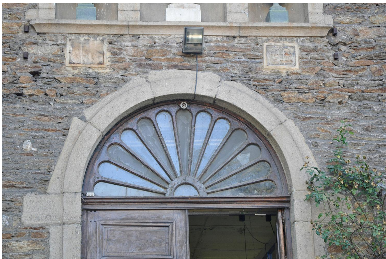
Détail tympan entrée principale
