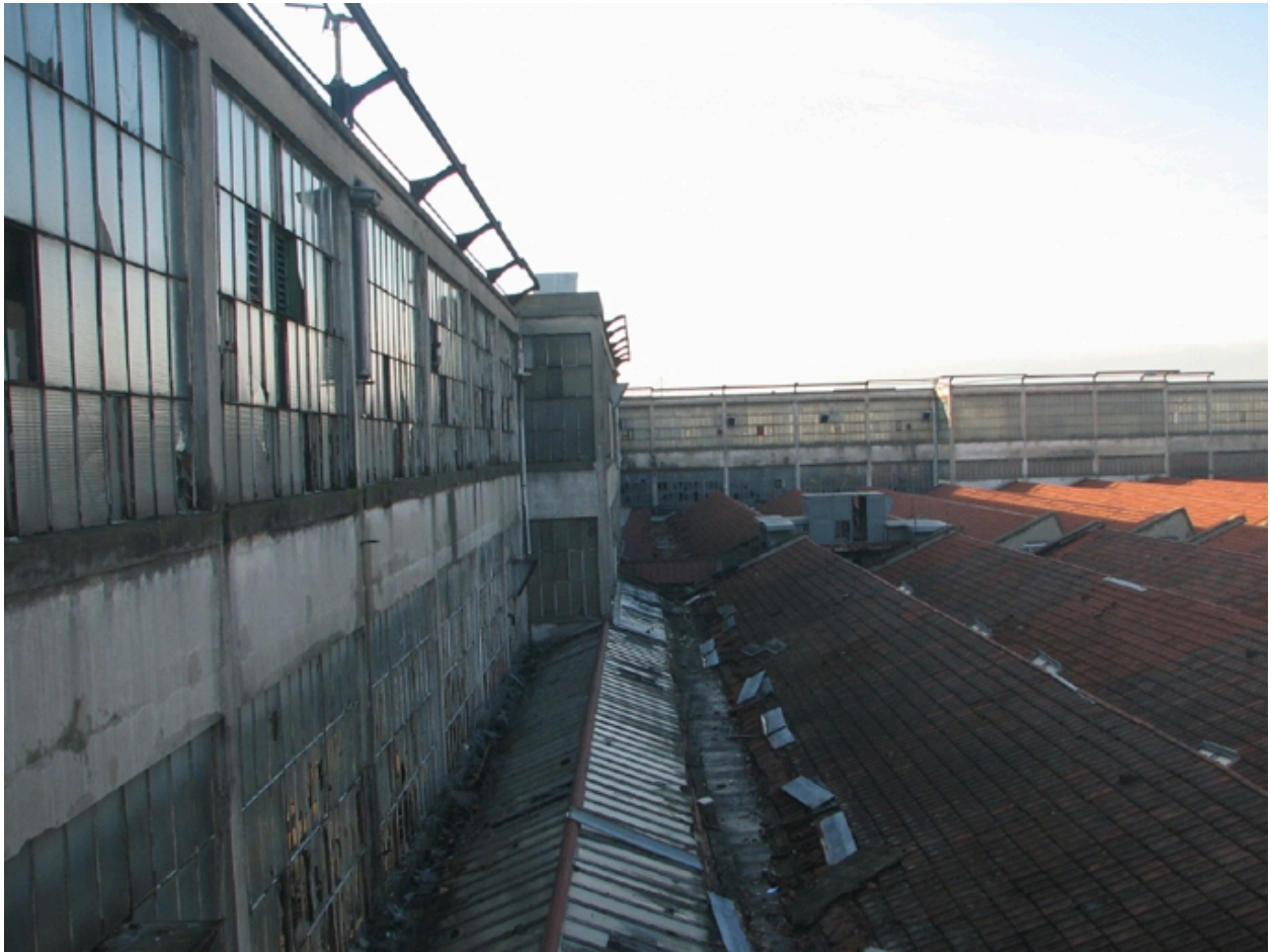
Détail toiture nord-ouest
