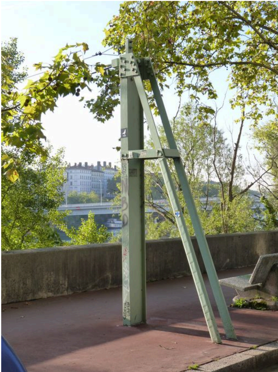
Structure métallique subsistante en rive droite
