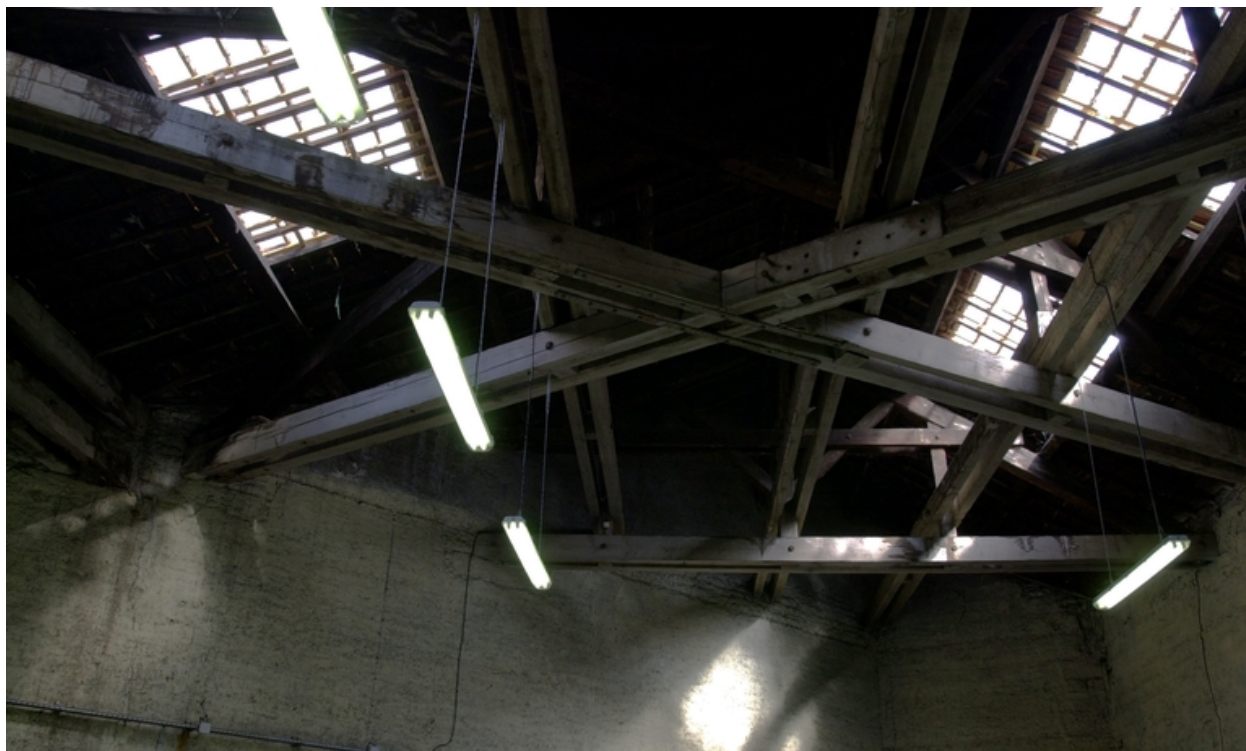
Charpente bois et renfort bois
