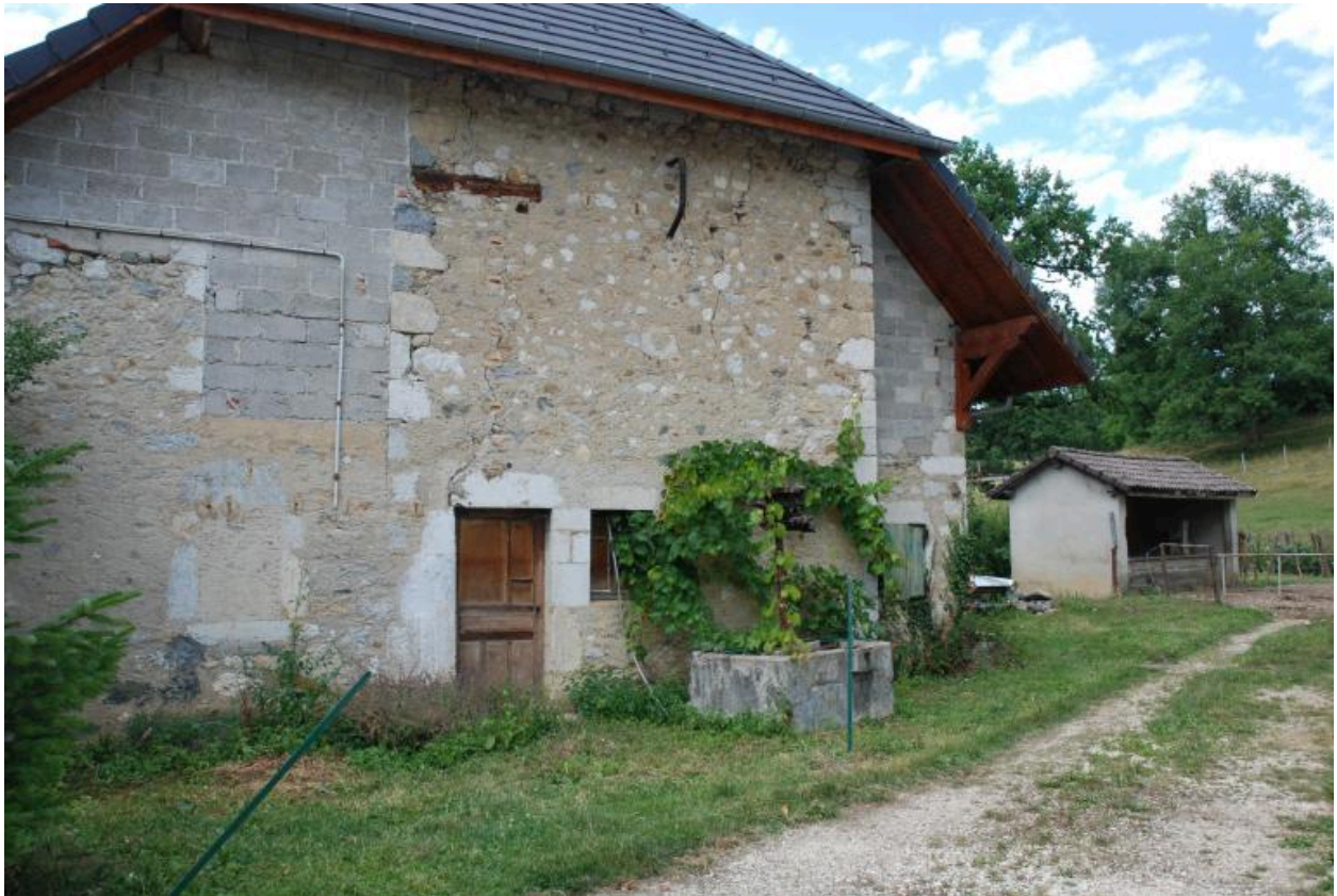
Vue d'ensemble, avec le bassin à l'arrière-plan.
