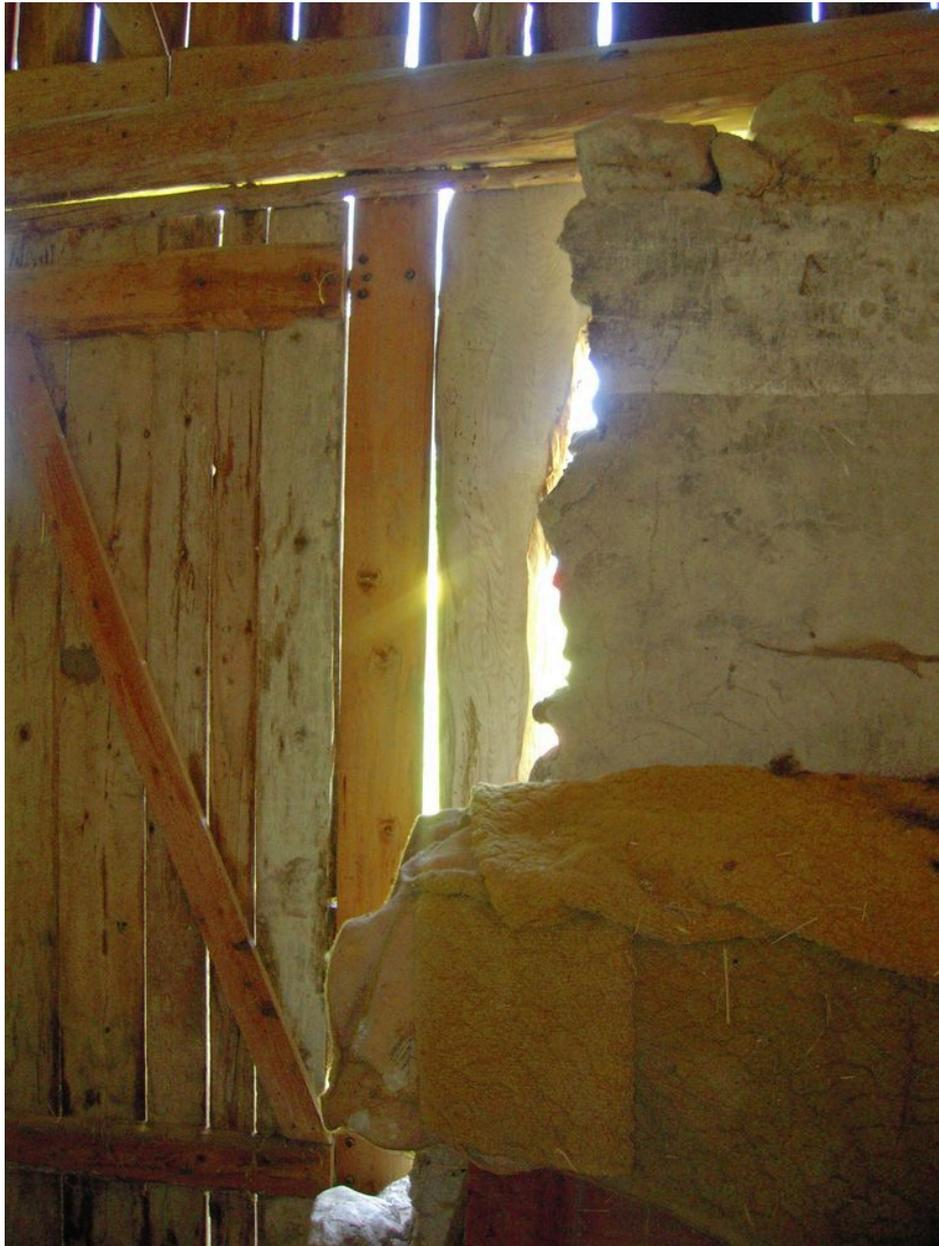
Vue intérieur du mur nord remplacé par du bardage bois et restes de peinture sur la partie maçonnée.
