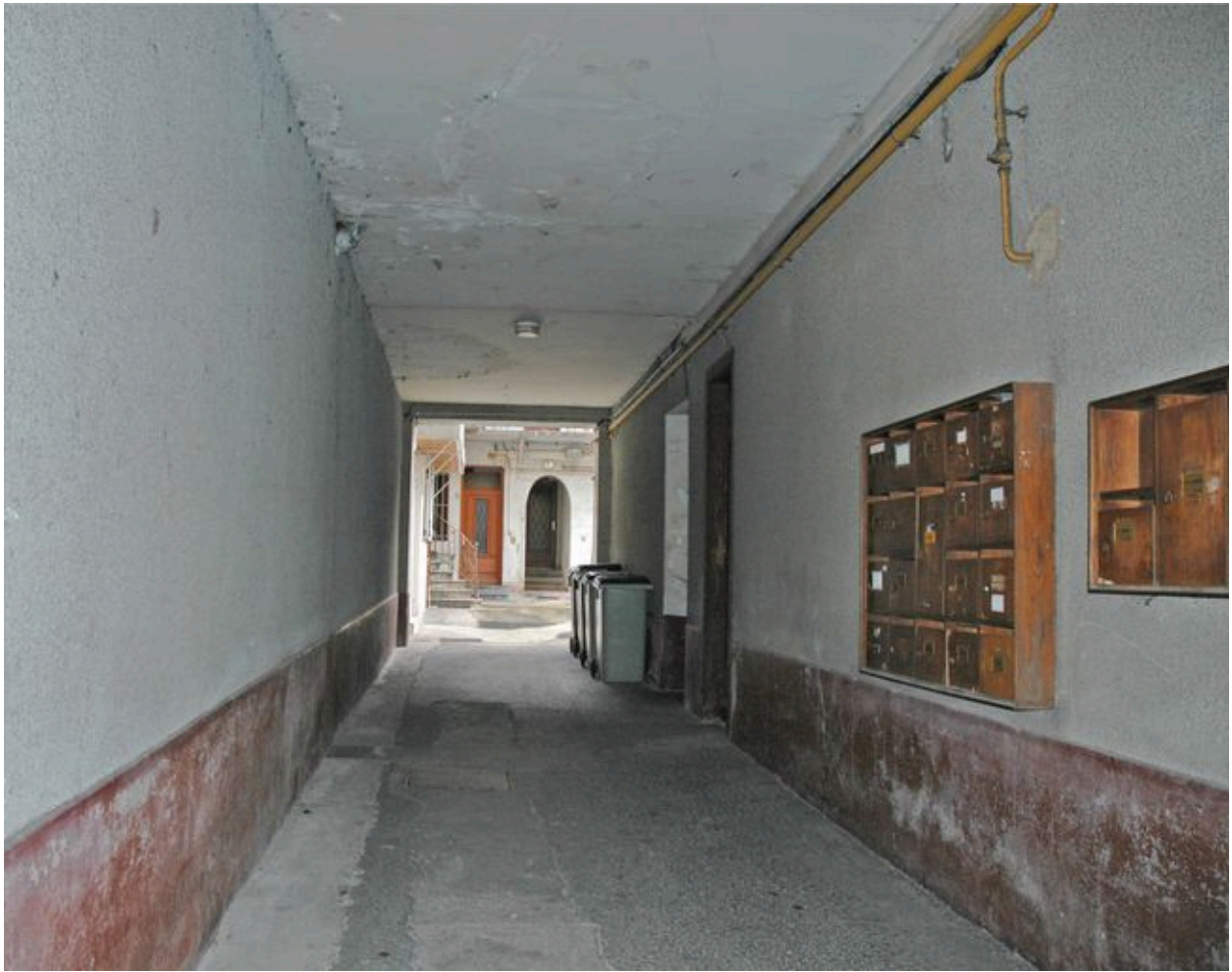
Passage couvert commun avec l'immeuble sur rue, vue depuis l'ouest
