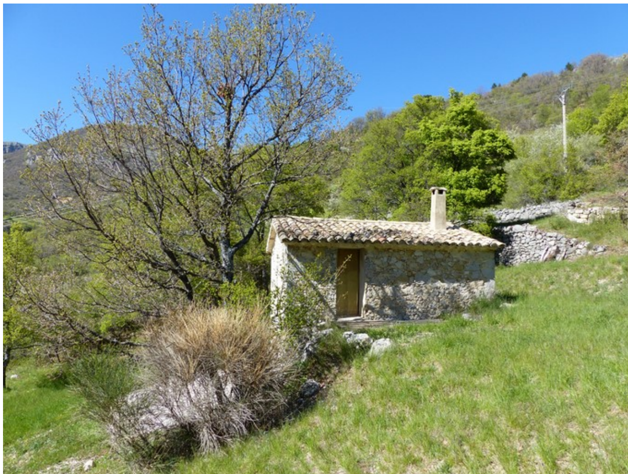
Entrepôt agricole, au quartier de Font Nouvelle.
