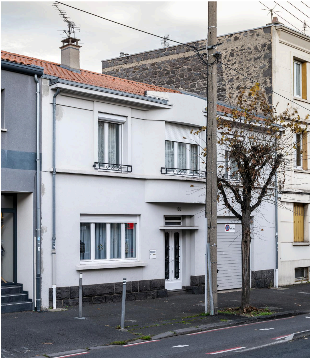
Façade sur le boulevard Jean-Jaurès
