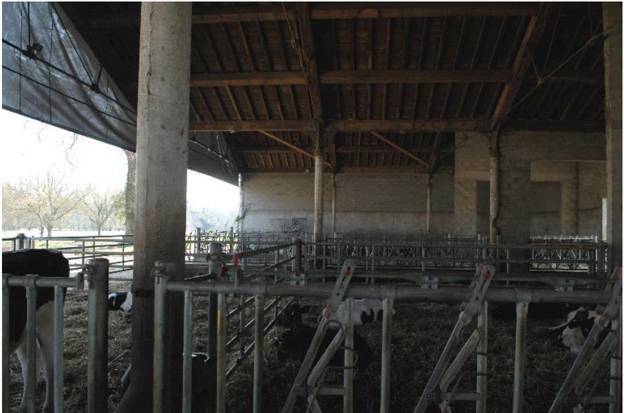
Niches à veaux et silos, vue intérieure depuis le nord
