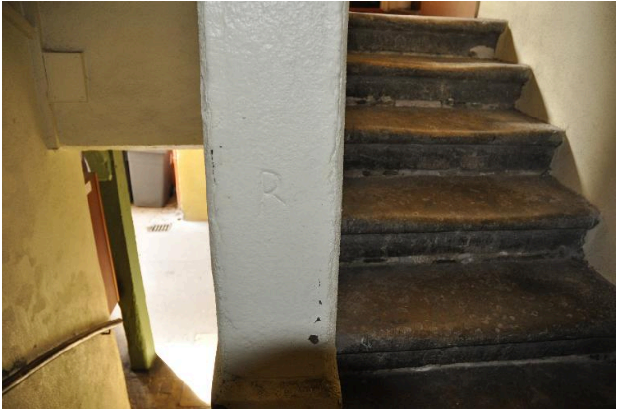
Vue de l'escalier de l'immeuble sur rue
