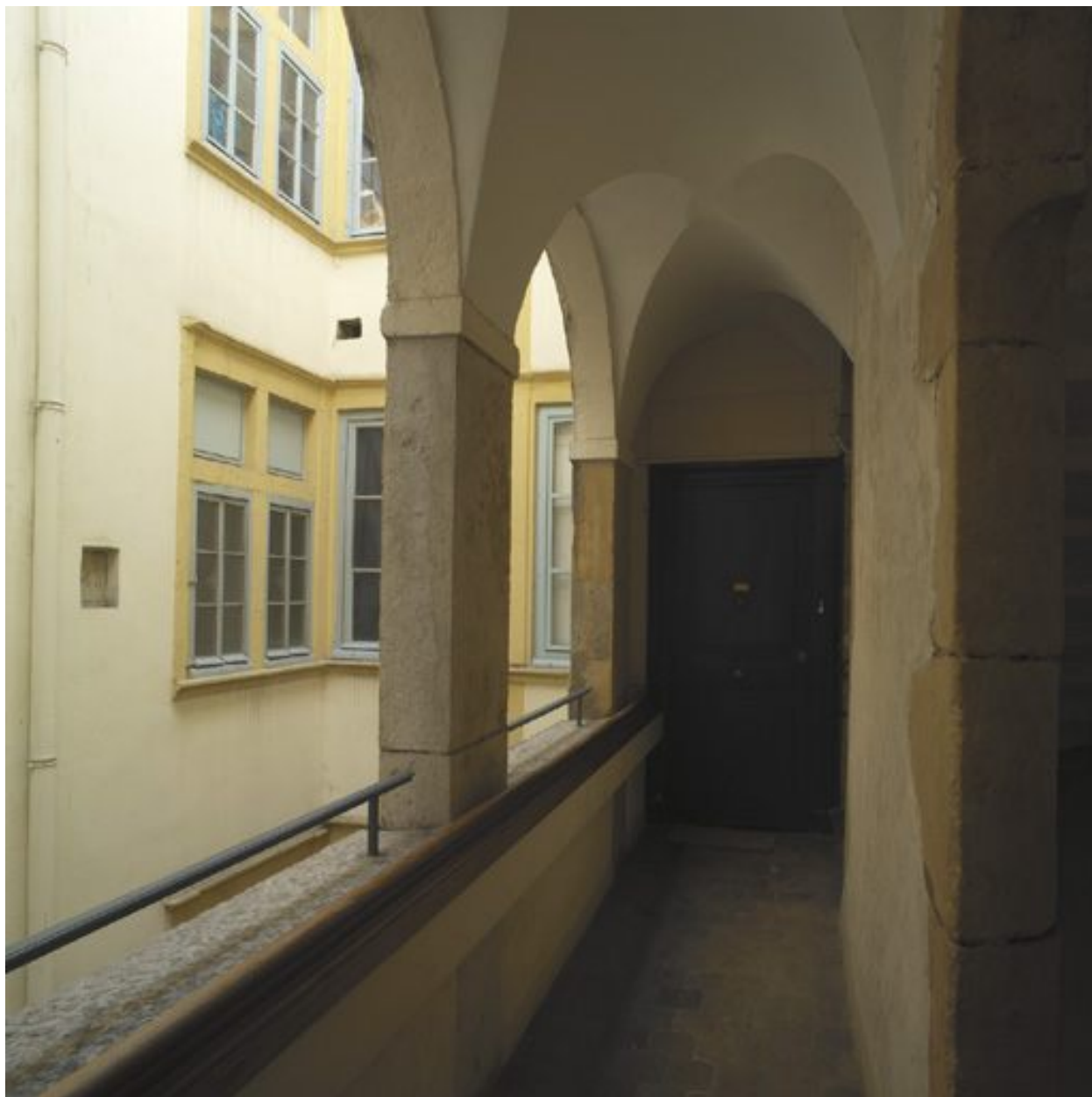
Cour sud et palier du deuxième étage carré
