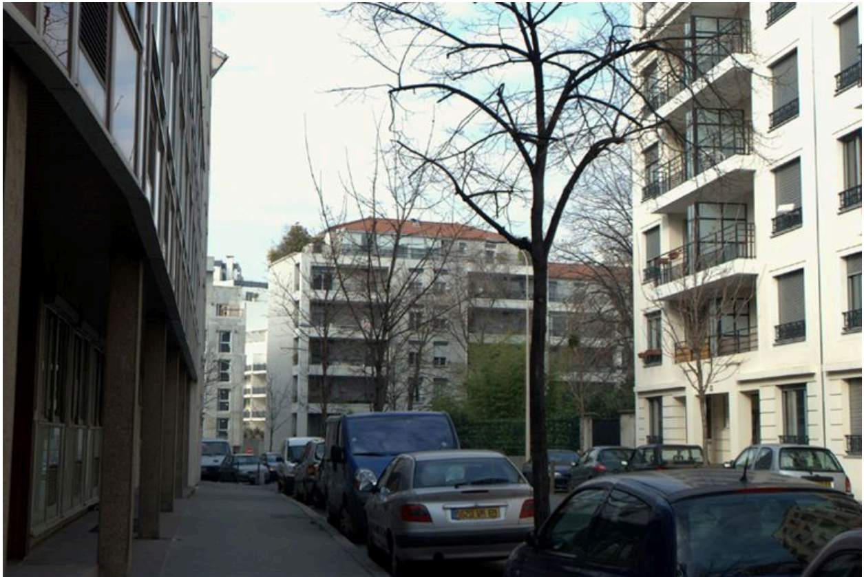
Élévation postérieure, depuis la rue Jules Brunard
