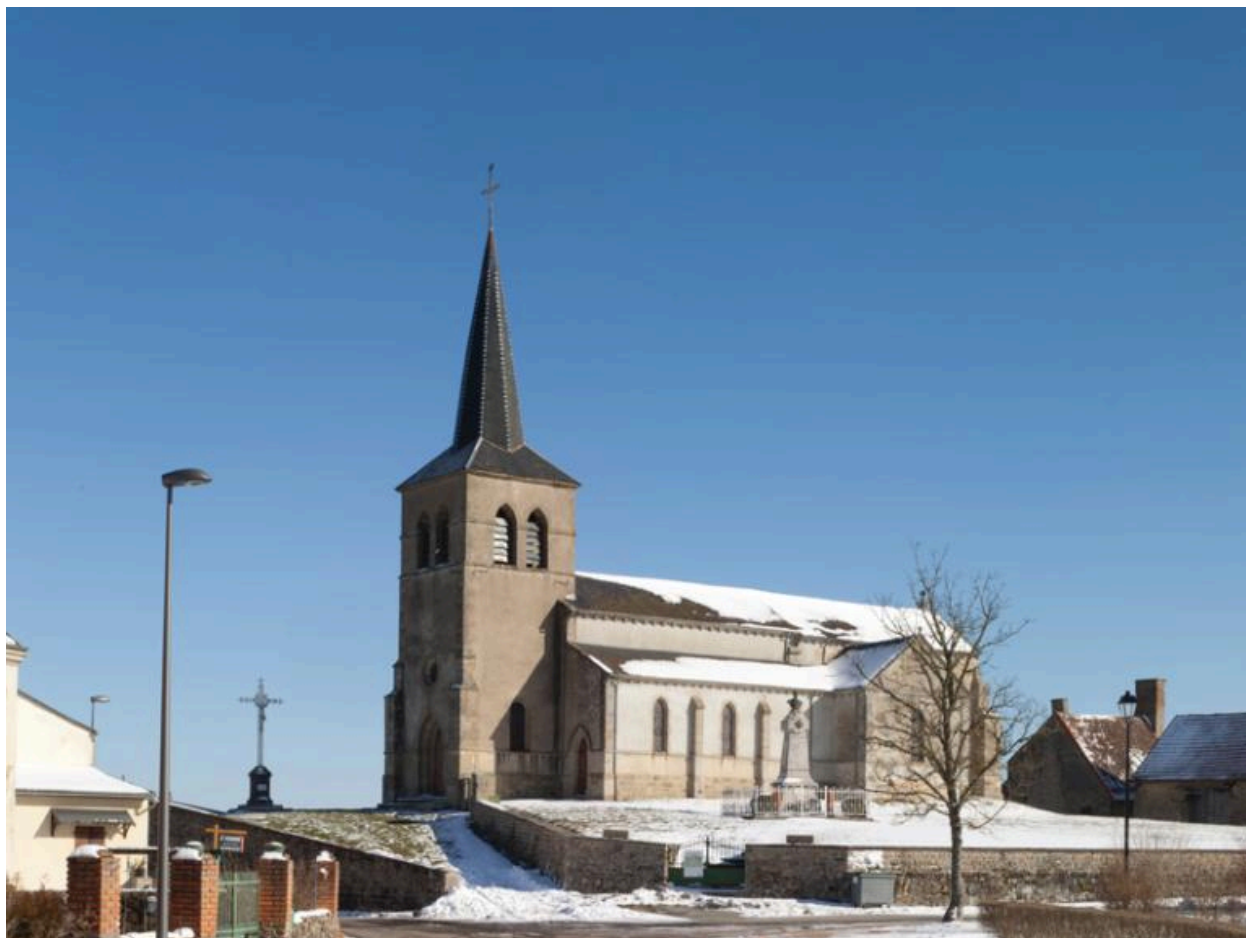
Vue générale de la façade méridionale.
