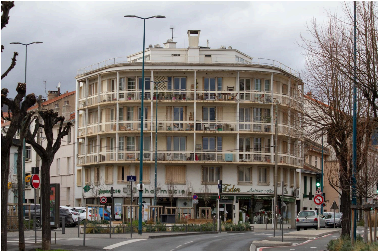
Façade sur la place Littré
