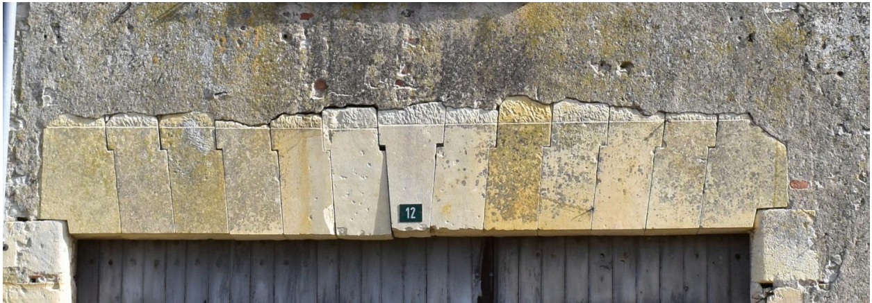
Maison, 12, rue d'Allier, parcelle cadastrale B01 : 1132. Détail du linteau à crossettes, limite du 18e siècle et 19e siècle.
