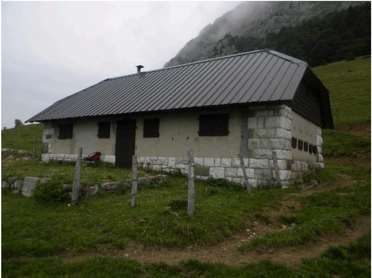
Vue de la façade principale du bâtiment d'habitation.
