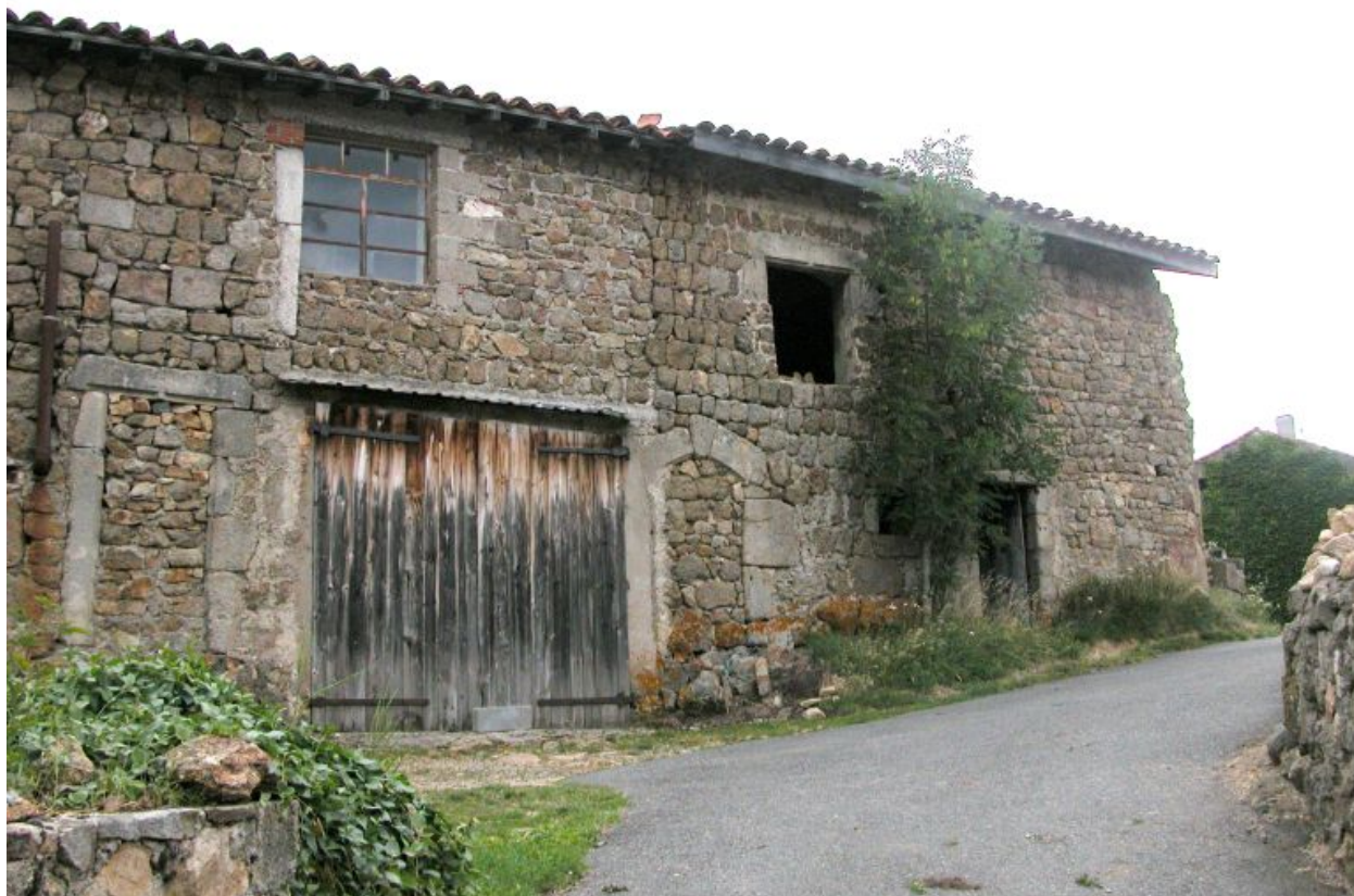
Vue d'ensemble du côté droit de l'édifice.
