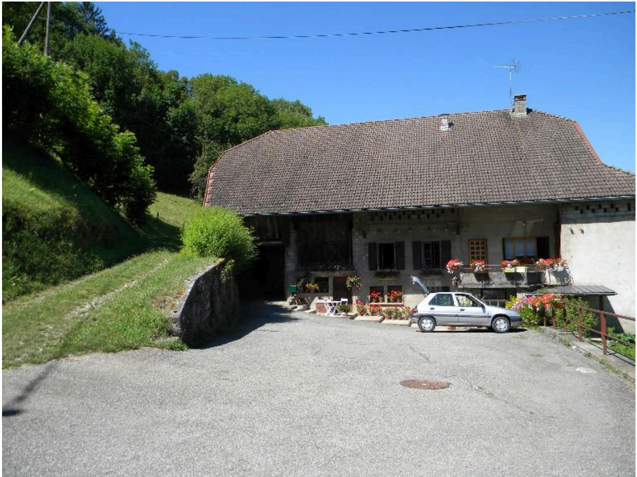
Vue de la façade arrière.
