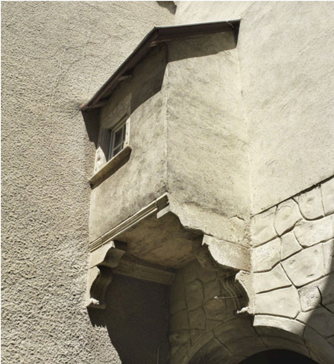
Logette au-dessus du corps de passage.
