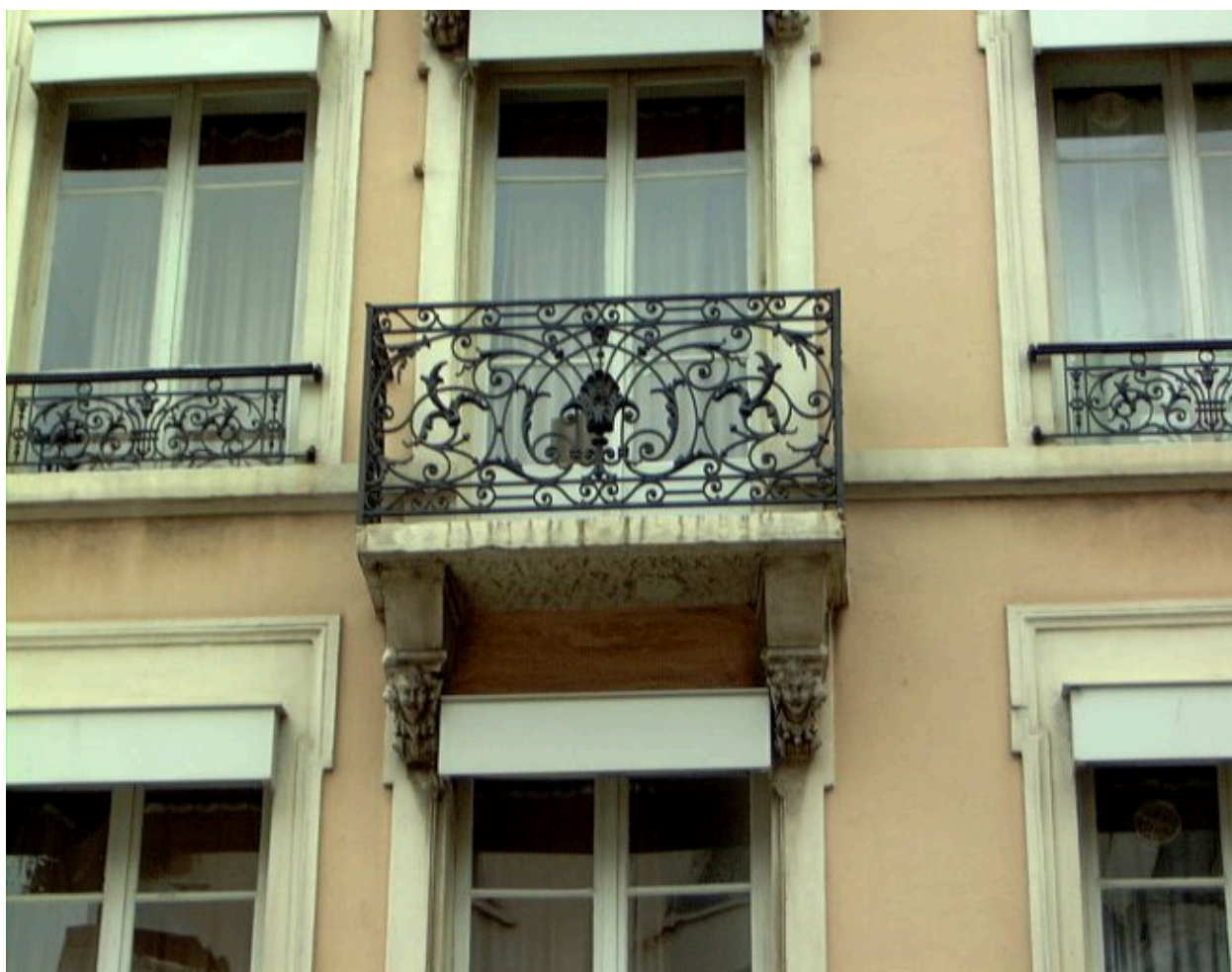
Détail du balcon et du garde-corps
