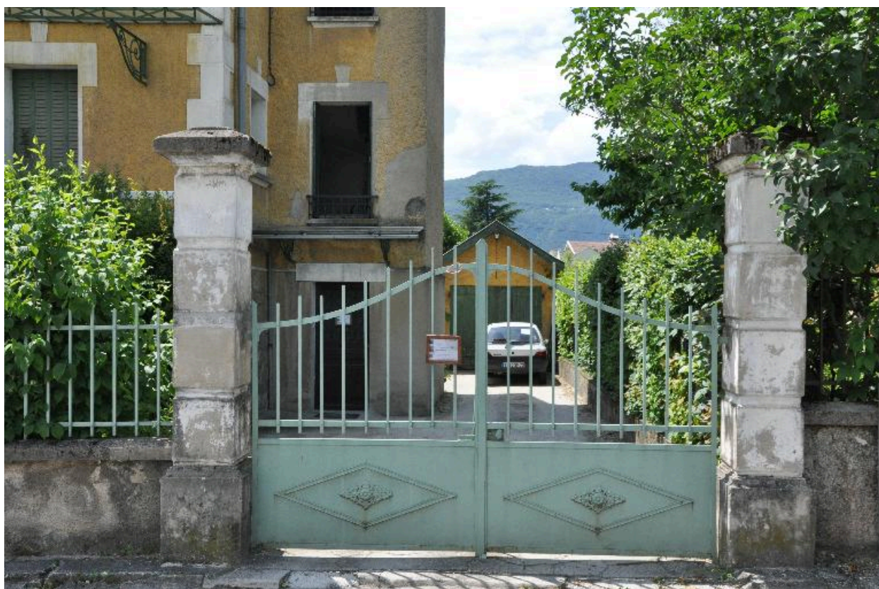
Portail d'entrée et communs à l'arrière
