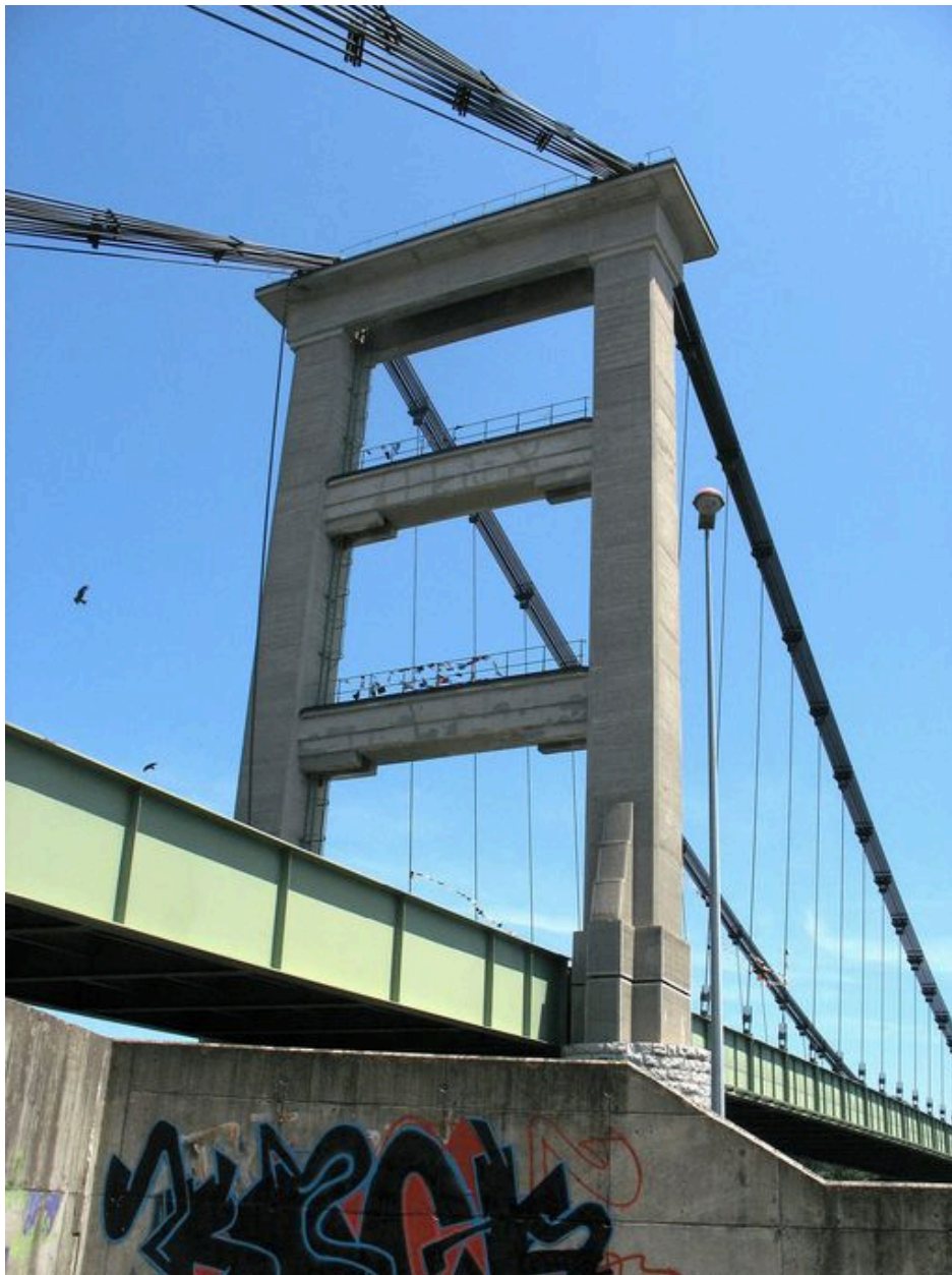
Vue du pylône de la rive droite (côté Le Teil)
