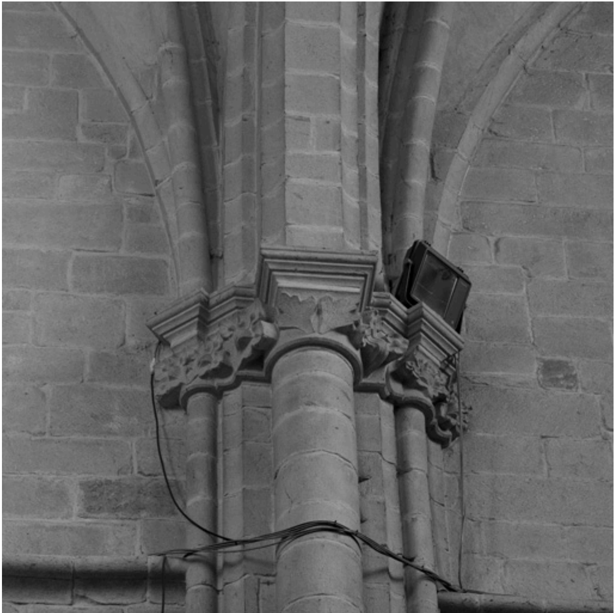
Détail de chapiteaux : support entre les travées V et IV (?).
