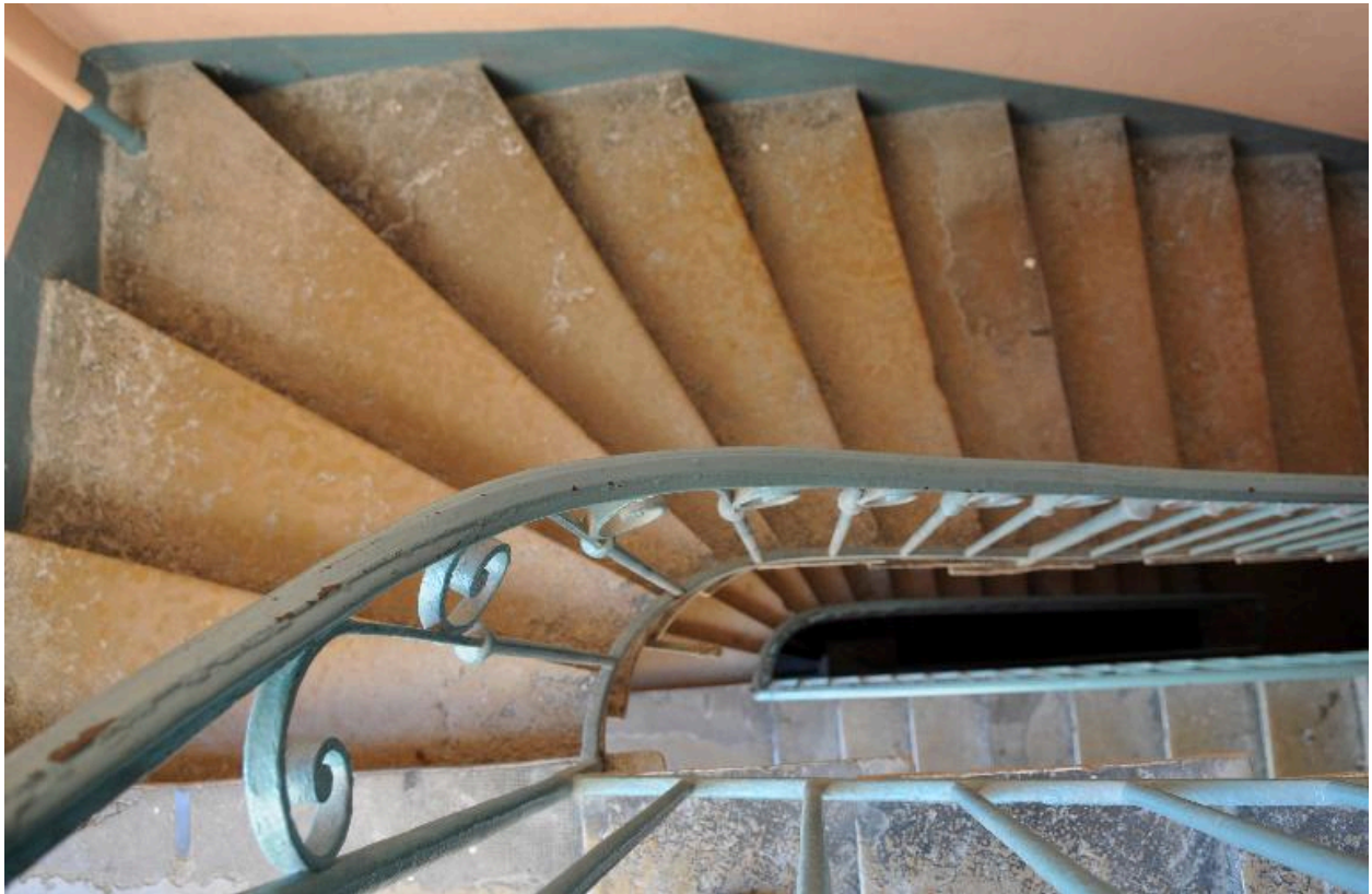
Vue intérieure : la cage d'escalier vue en plongée
