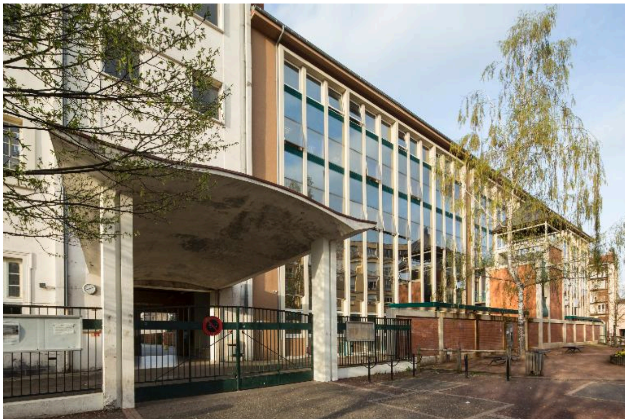
Bâtiment B et bâtiment H : entrée du lycée
