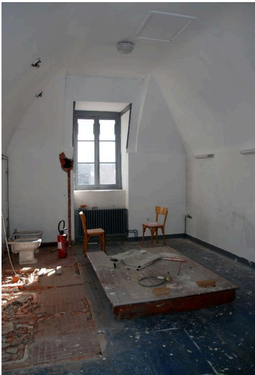
Château, pièce voûtée au dernier étage du pavillon sud-est
