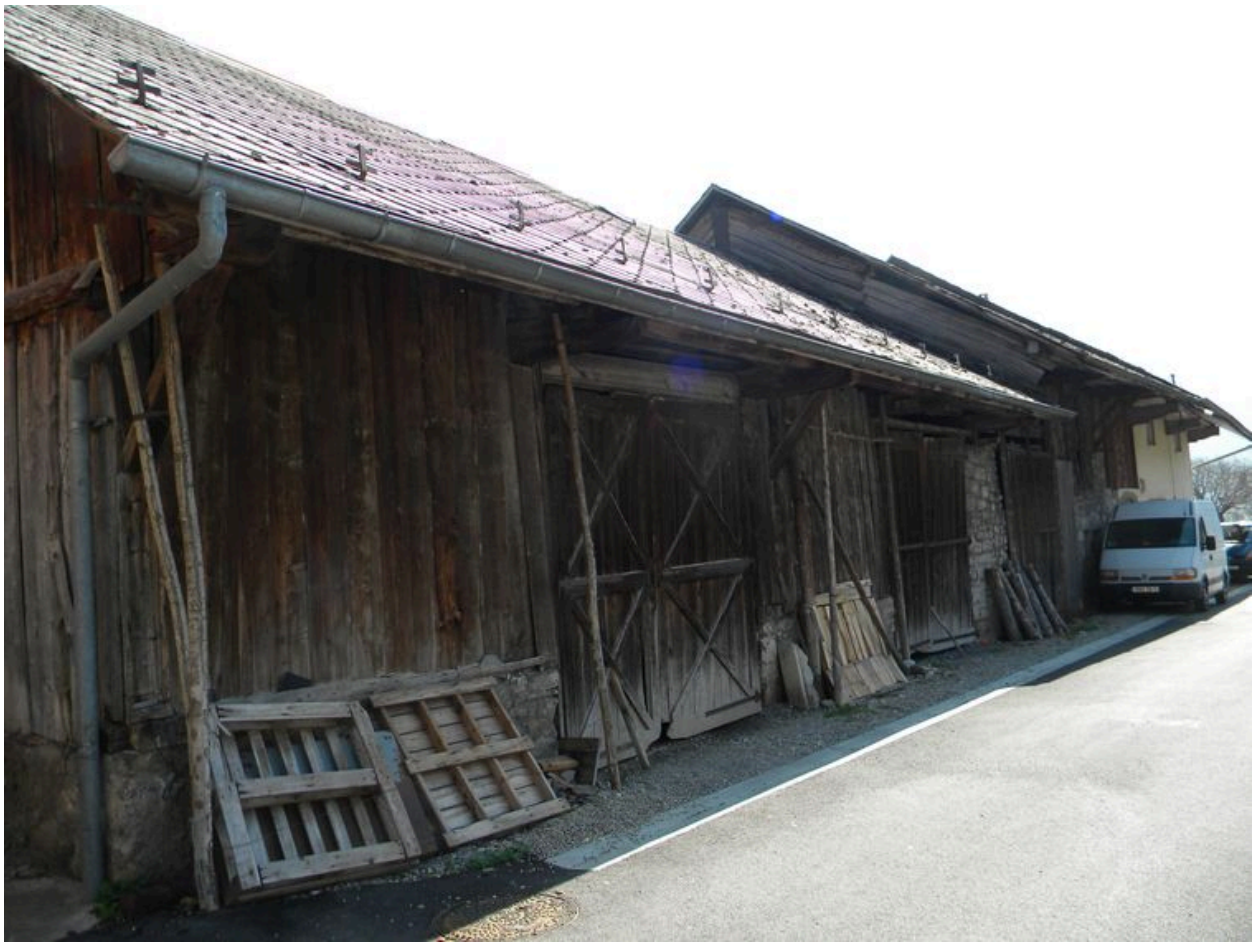
Alignement de façades de bâtiments agricoles vue depuis le nord. (B7 1268, 1269, 1270, 1271, 1272, 2012).
