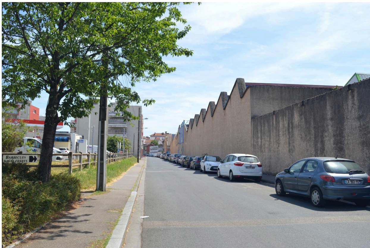
Usine Chimitechnic - vue depuis la rue Marx Dormoy
