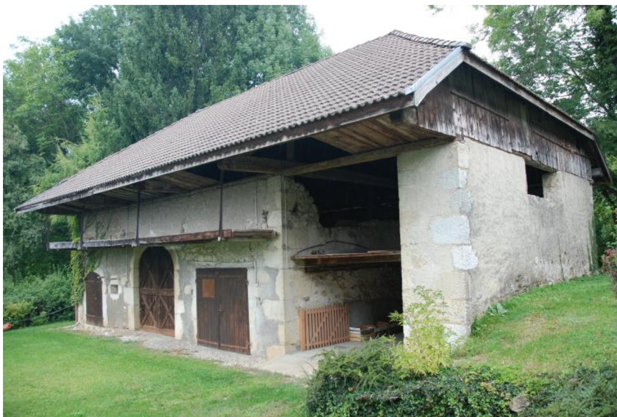
Vue d'ensemble de la grange-étable.
