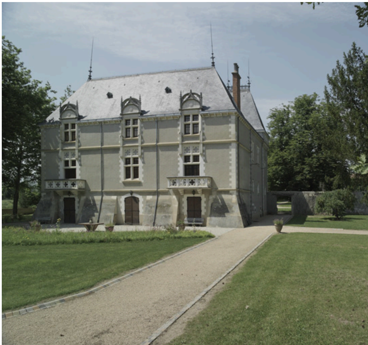
Vue d'ensemble de la façade sud, de trois-quarts sud-est.
