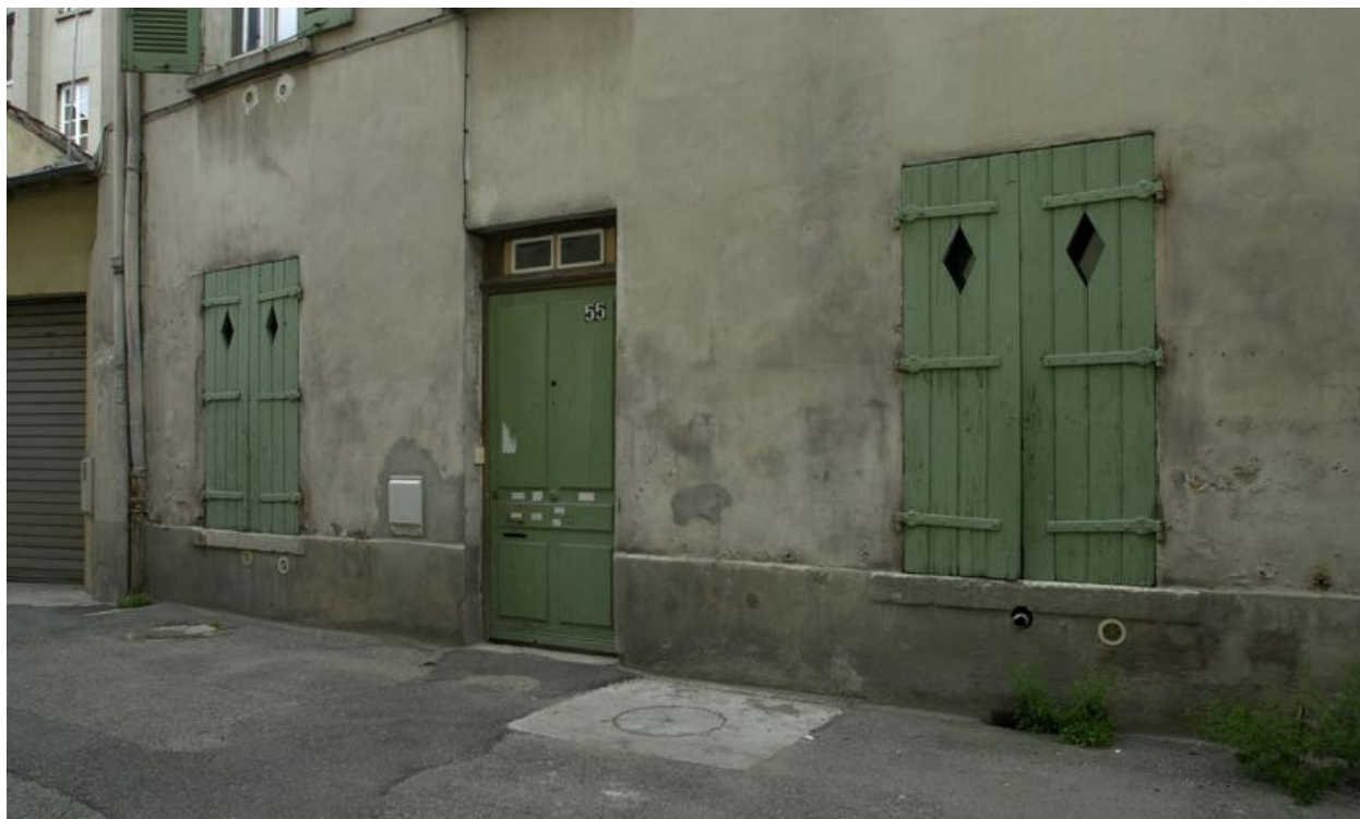
Détail du rez-de-chaussée, impasse Rival
